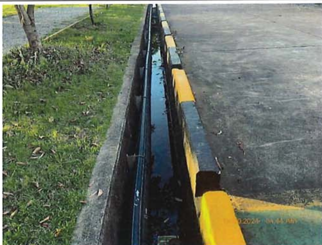
ภาพที่ 17 ระบบระบายน้ำเสียแยกออกจากรางระบายน้ำฝน
