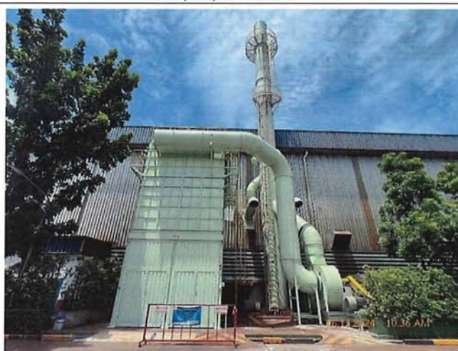
ภาพที่ 4 ปล่องระบบดักฝุ่นจากขั้นตอน Finishing & Grinding (BH4)
