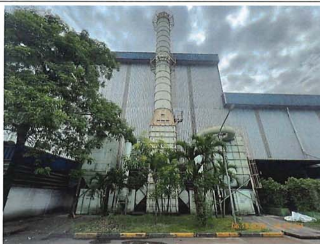
ภาพที่ 2 ปล่องระบบดักฝุ่นจากขั้นตอน Sand preparation (BH2)
